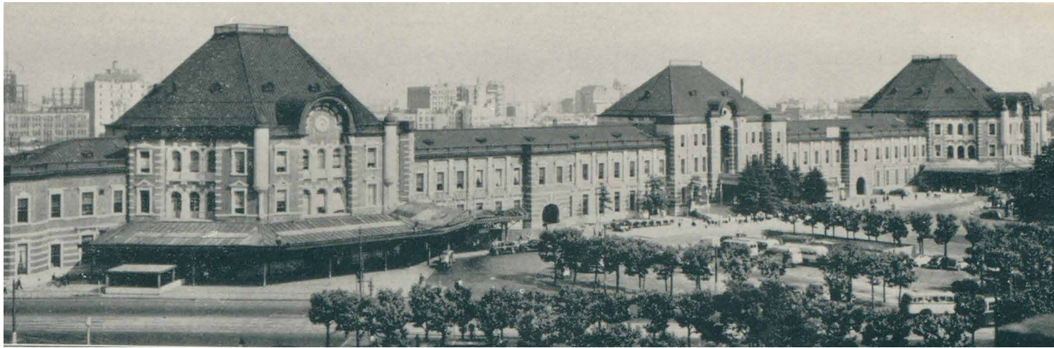
国鉄・東京駅（復旧）（東京都／昭和 26 年）
