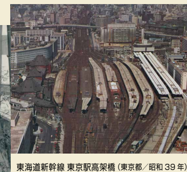
東海道新幹線 東京駅高架橋(東京都/昭和39年)
